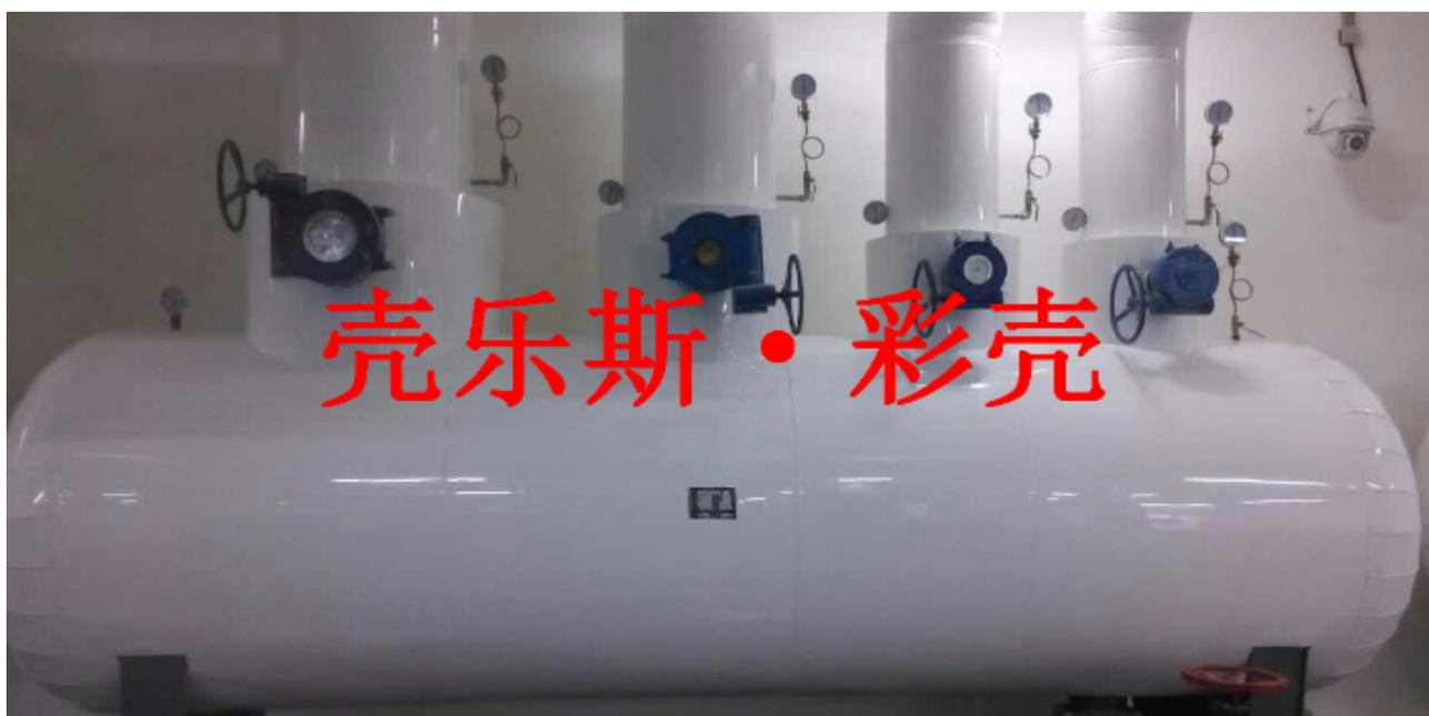
PVC彩色保温外壳，是一种特种的复合材料，产品预制成型，便于安装，是一种整洁统一、干净美观的，可以适用于各种管道及设备的外保护及其保温外包外壳的系统。PVC彩色保温外壳，有着明亮的外表不产尘、不积尘，可以经久保持洁净，清洗方便，并有防腐蚀，耐酸碱的特性，而且它还有抗紫外线、抗老化的功能，因此可适用于室内外，有酸碱环境等多种场合。PVC彩色保温外壳，彩色和白色产品可以应用于室内，颜色鲜亮，系统清晰。室外建议用白色的产品，大方整洁，正常使用材料寿命长达10年。浙江安装方便彩色保温外壳货源充足PVC保温外壳安装方式：胶水粘接、螺纹钉固定、单面胶带粘接、双面胶粘接。
