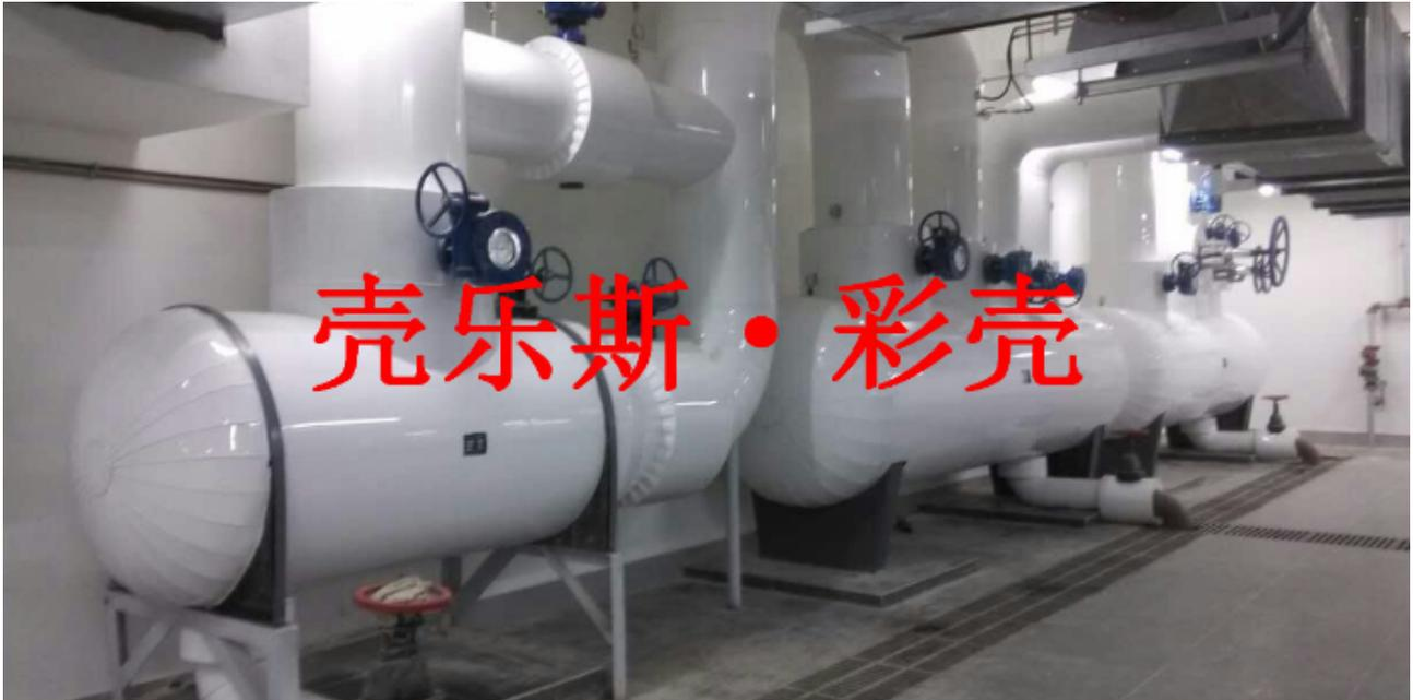
壳乐斯·彩壳·彩壳系列产品□ PVC保温外壳已经预留了30-50mm的搭接□overlap□□先安装PVC保温外壳管件（弯头、三通、管帽等），再安装PVC保温外壳直管□PVC保温外壳若选择配套的双面胶带安装时，要将双面胶带沿着边缘搭接外层的内壁，离外边缘1-2mm处顺着长度的方向均匀贴布过去，形成一条直线，然后包在管道上，对齐合拢时撕去双面胶带的外层纸用力顺着长度方向均匀按实PVC保温外壳即可，然后用PVC配套胶水跳点滴在双面胶带粘合处，使PVC保温外壳搭接处更加密合且牢固。美观同时，也起到密封作用。
